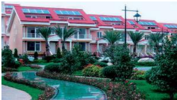
图 4.3 云南昆明与建筑结合的太阳能热水系统
